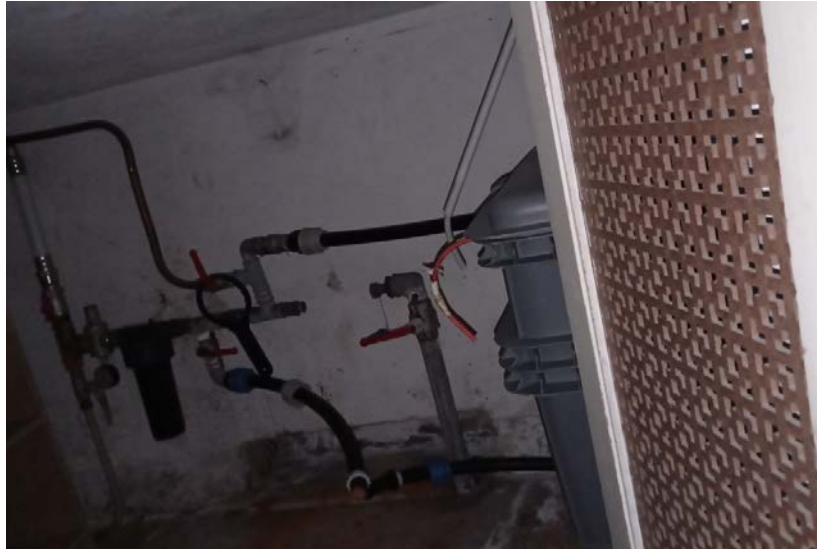
Vano sottoscala con arrivo dell'acquedotto. Si nota la tubazione di arrivo sulla destra e lo spazio che era occupato dal contatore (ora rimosso)
